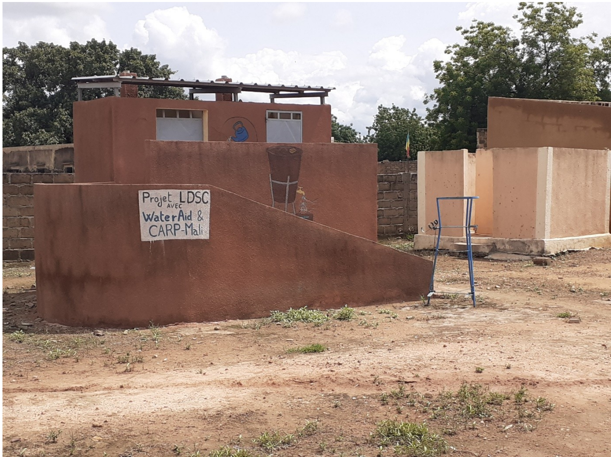
Photo 2: Les toilettes construites par l'ONG Water-Aid pour l'ASACOSAMA, septembre 2023
