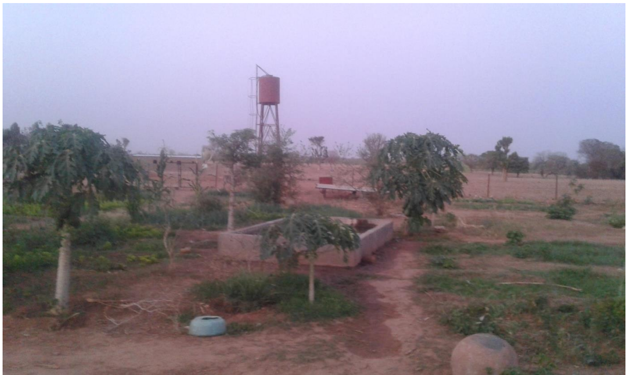
Photo 3 Château d'eau plus les panneaux solaires pour tirés l'eau (source enquête personnelle, avril 2018).
