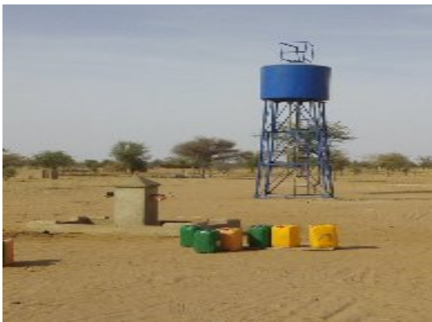
Photo 6 : Forage réalisé par la direction régionale de l'hydraulique de Mopti
