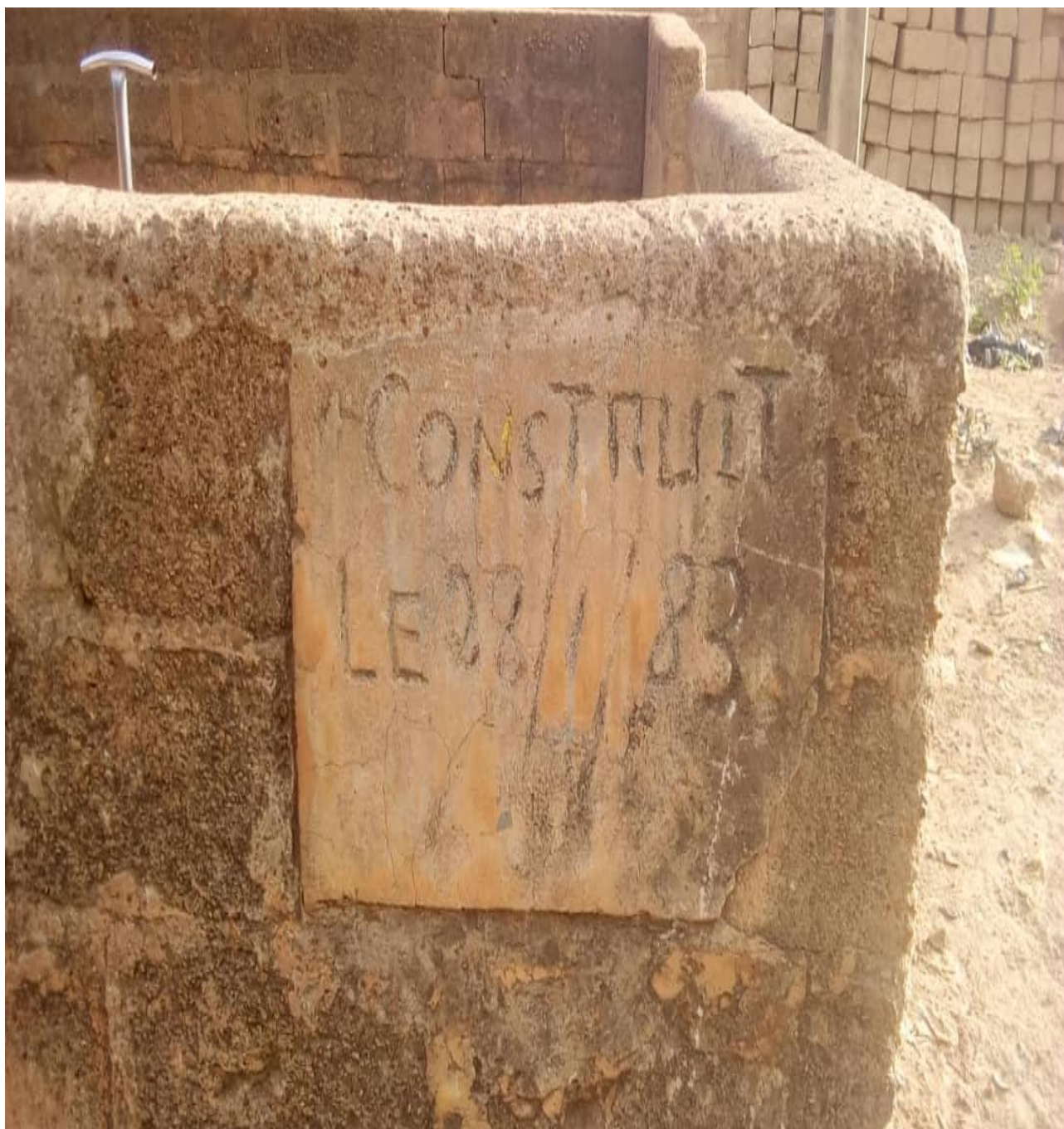
PHOTO N°6 : L'arrière de la fontaine construit 28/01/1983 à Médine derrière l'hôpital
