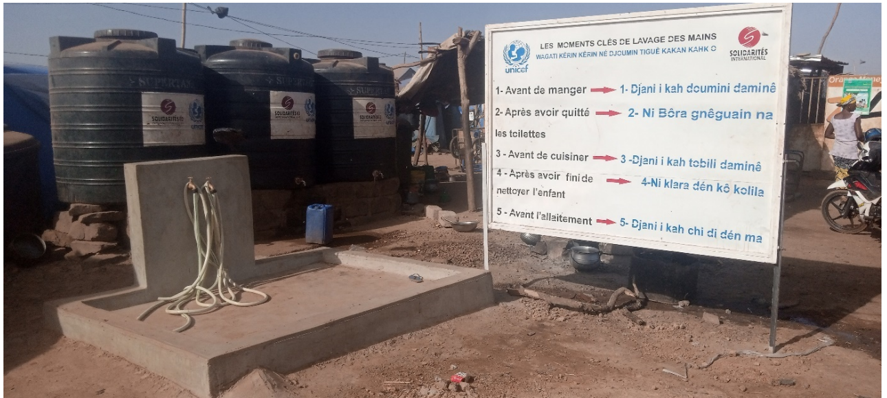
Le nouveau robinet installé au camp de Niamana par Solidarité internationale
