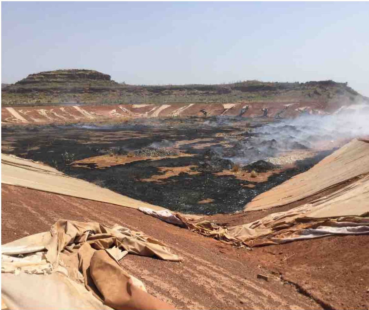
Photographie 9 – Décharge finale de Noumoubougou, la cellule A en feu, la paroi est couverte de bâches (en piteux état) pour éviter au lixiviat de pénétrer dans le sol (Crédit photo : Bakary Traoré, le 21/04/2021)
