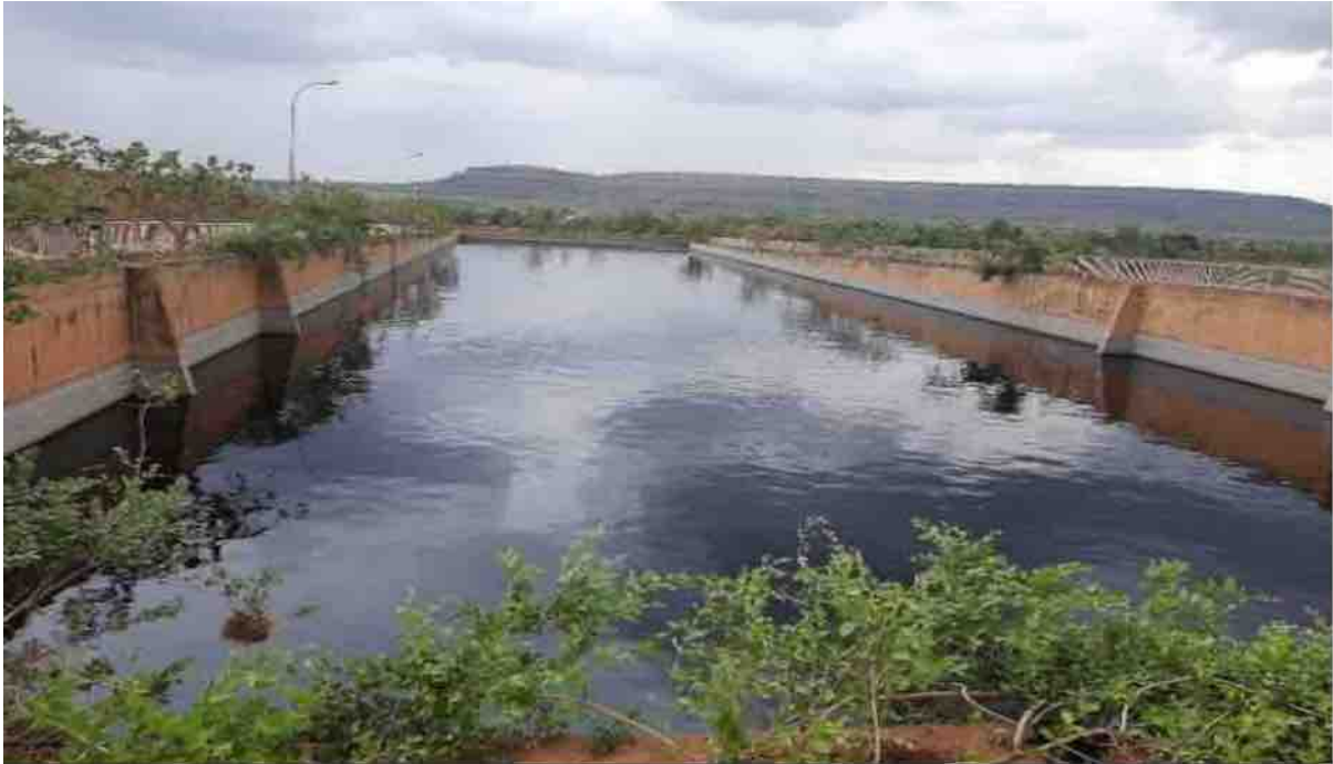
Photographie 7 – Décharge finale de Noumoubougou, bassin de décantation où se déverse le lixiviat (Crédit photo : Bakary Traoré, 17/06/2022).
