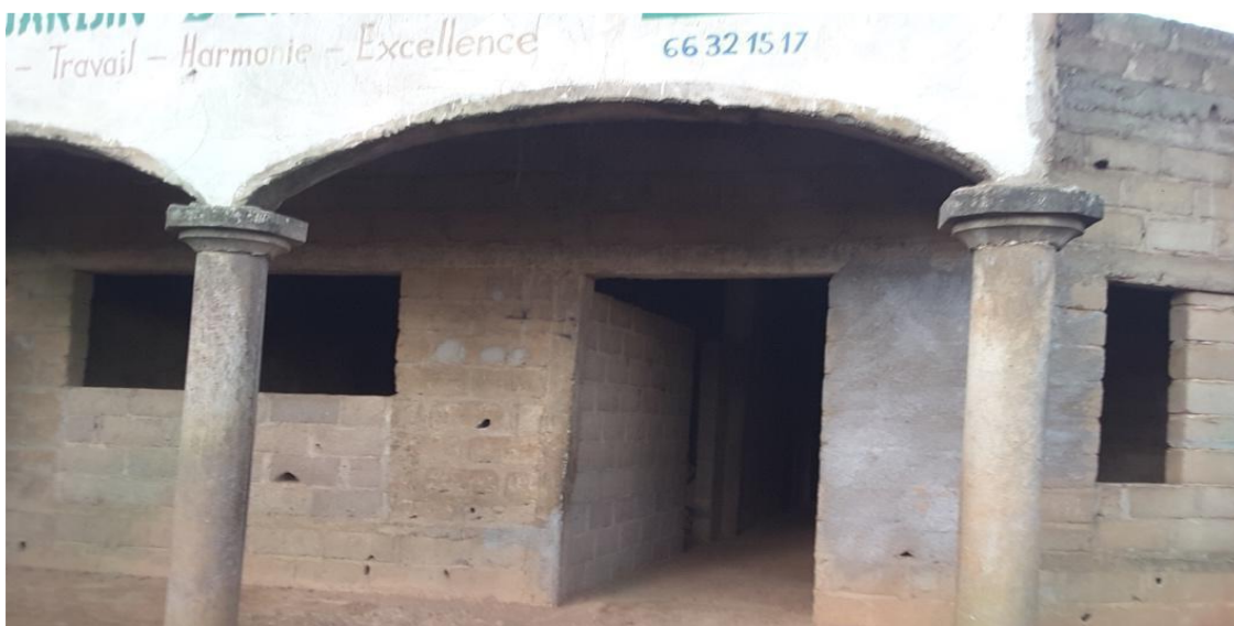
Source : enquête de terrain, École privée à Kabala-Est, une villa inachevée devenue école, 2022
